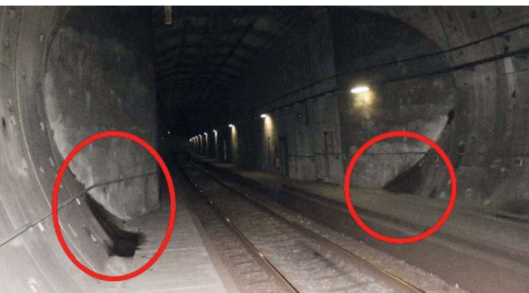
Impressie van te herstellen tunnelementen.
