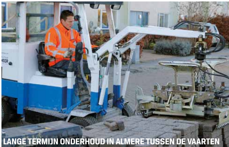
De Optimas machine waarmee zowel mechanisch alsook met vacuüm straatwerk aangebracht kan worden.
