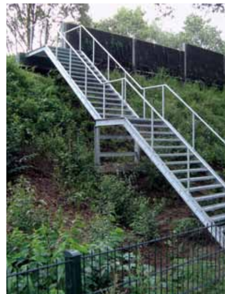
Op maat gemaakte staalconstructies.
