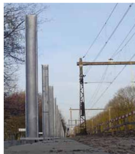
Het geluidscherm is geplaatst via het inspectiepad en daarmee werd overlast voor omwonenden en treinreizigers tot een minimum beperkt.
