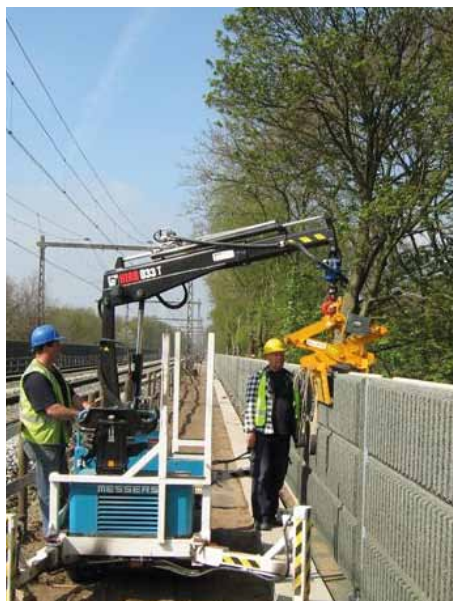
Speciaal ontwikkelde machine voor het plaatsen van de prefab elementen.
